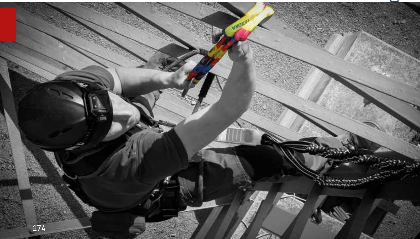
TX/L-Compact WIRE „black“ mit Stahlseileinlage
