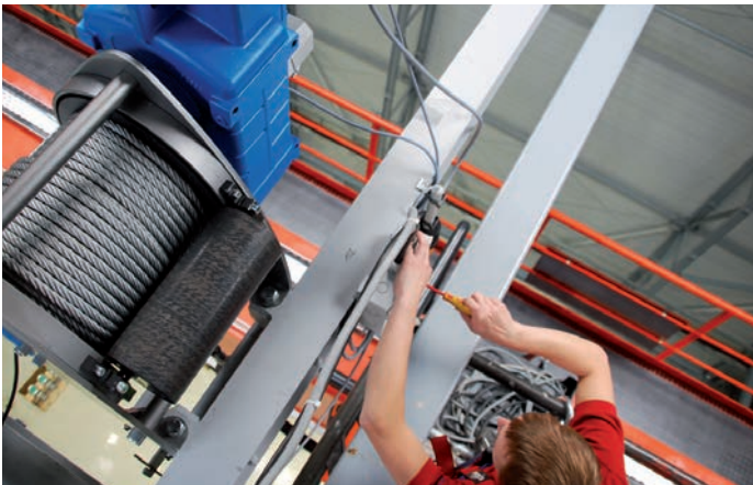
Kranabnahme durch Sachverständigen
