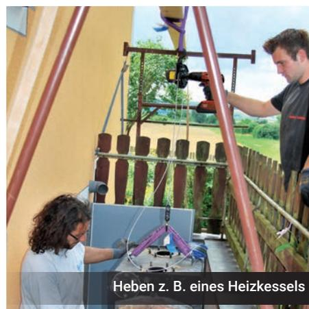
Heben z. B. eines Heizkessels
