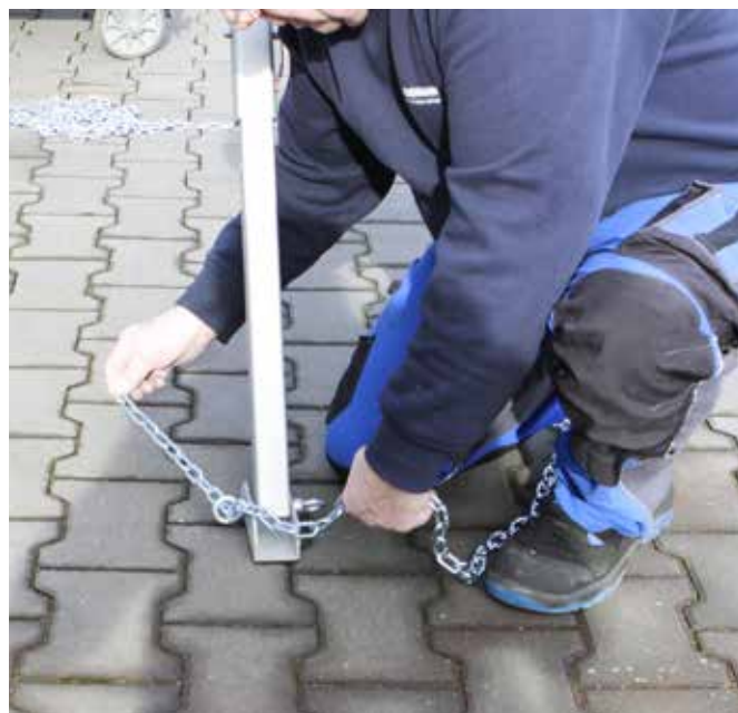
Abb. 17 + 18: Sicherungskette durch die Öse am 2. Fuß fädeln und bis zum 3. Fuß weiter durchziehen.
