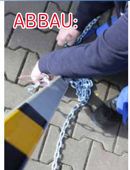
Abb. 51: Zum ABBAU das HSG in umgekehrter Reihenfolge zurückbauen und dann zuerst die Sicherungskette wieder entfernen.
