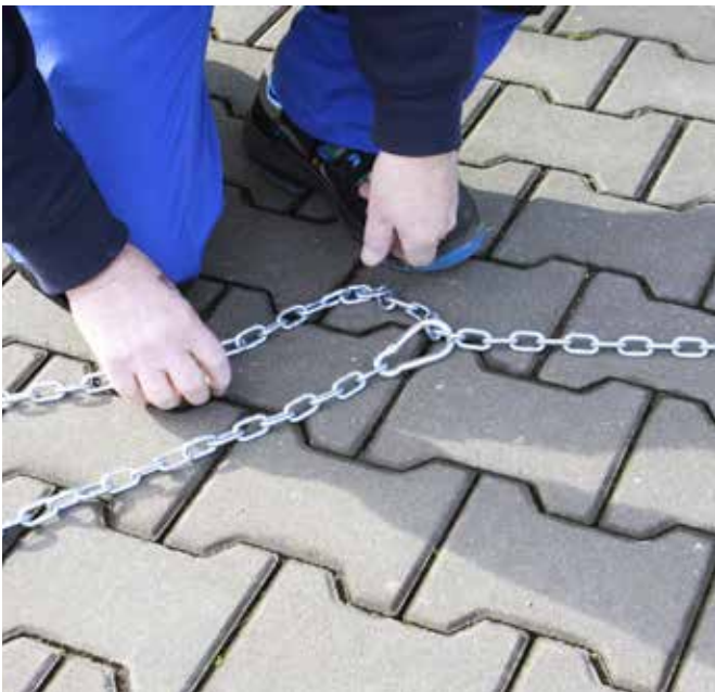
Abb. 23 + 24: Anfangsstück der Sicherungskette mittels mitgelieferten Karabiner an der durchgezogenen Sicherungskette befestigen.
