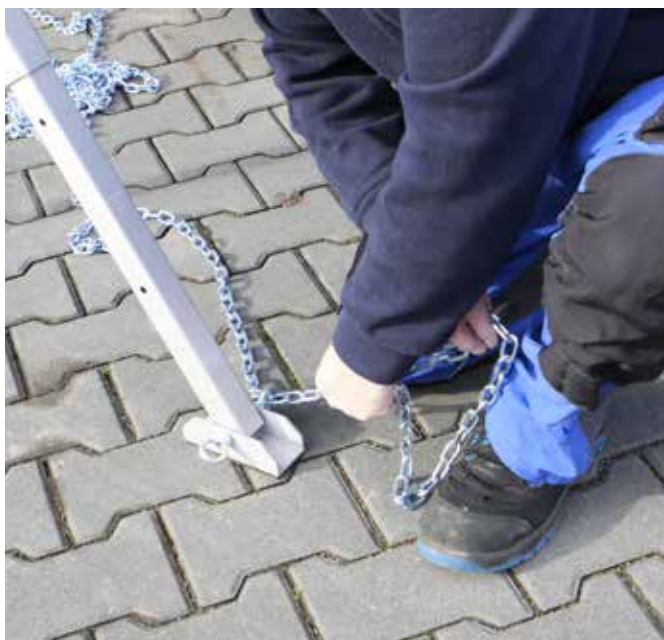
Abb. 17 + 18: Sicherungskette durch die Öse am 2. Fuß fädeln und bis zum 3. Fuß weiter durchziehen.
