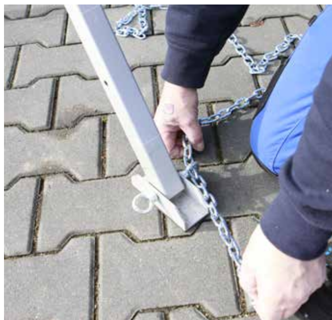
Abb. 15 + 16: Sicherungskette durch die Öse am 1. Fuß einfädeln und bis zum 2. (nächstgelegenen) Fuß weiter durchziehen.
