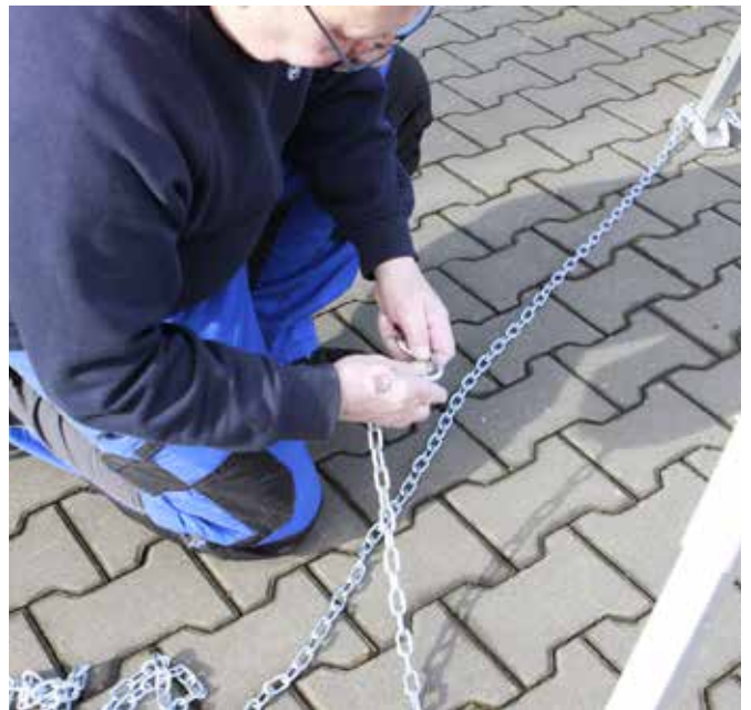
Abb. 21 + 22: Sicherungskette weiter bis zum Anfangsstück ziehen. Darauf achten, dass die Kette leicht gespannt zwischen den Füßen sitzt.
