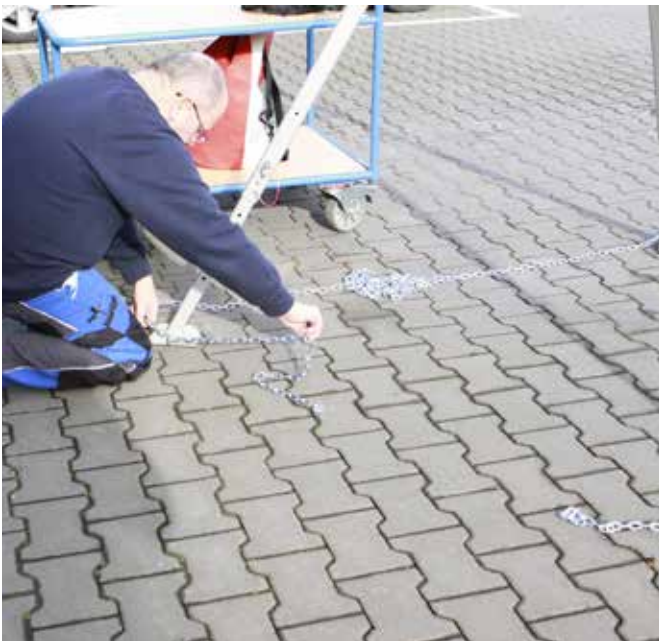
Abb. 21 + 22: Sicherungskette weiter bis zum Anfangsstück ziehen. Darauf achten, dass die Kette leicht gespannt zwischen den Füßen sitzt.
