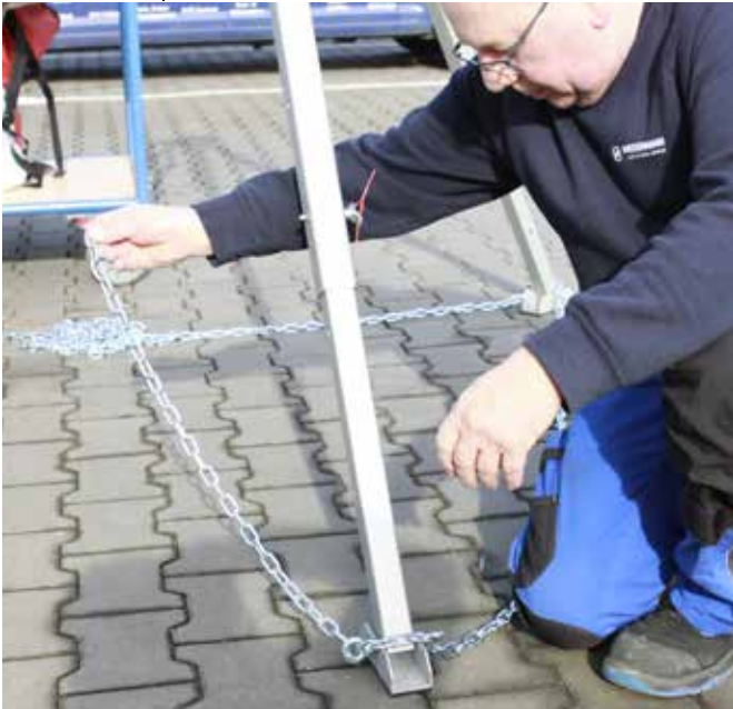
Abb. 19 + 20: Sicherungskette durch die Öse am 3. Fuß fädeln und weiter durchziehen.
