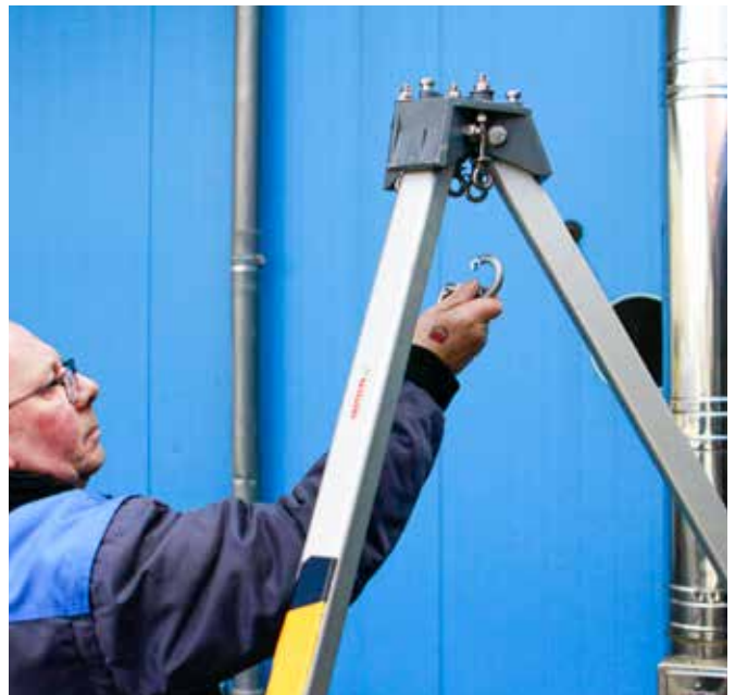
Abb. 31 + 32: Darauf achten, dass der Steckbolzen korrekt sitzt. Dann den Karabinerhaken am Dreibaum anbringen.
